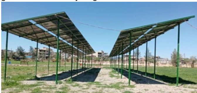
Eine bereits bestehende Fotovoltaikanlage in Dêrik
