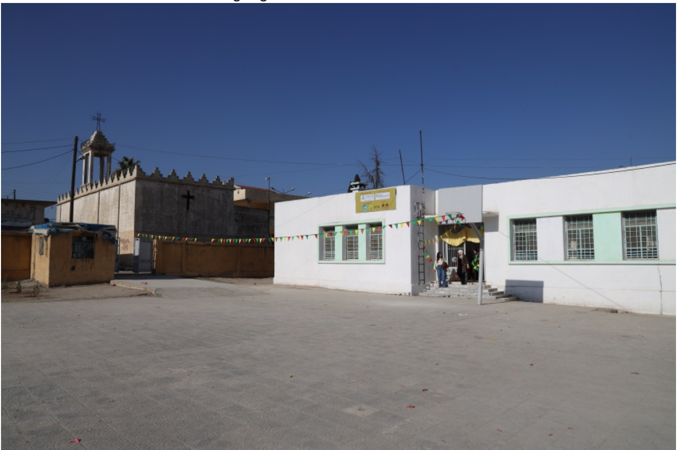
Die mit Mitteln von Global Care und Deutschland hilft neu renovierte Khader-Daoud-Schule direkt neben der chaldäischen Kirche in Dêrik
