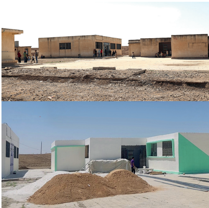
Die Karasor-Schule vor und kurz vor Abschluß der Sanierungsarbeiten
