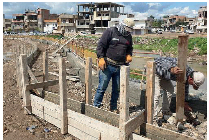
Schalungsarbeiten für Gehwege am Korniş
