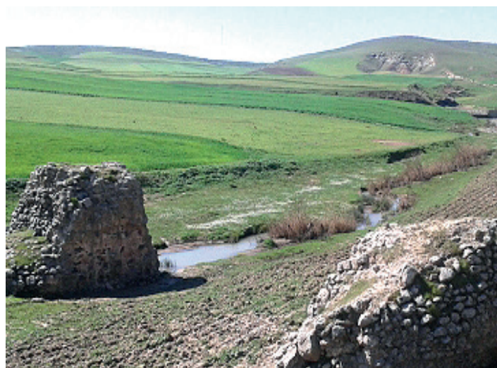
Fundamente der Brücke von Şakir Khache
